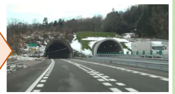
4車線化後(観音平トンネル)
